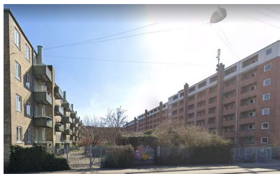
View fra Røvsingsgade og ind i gårdhave
