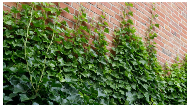
Beplantning på murværk i eksisterende garager
